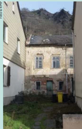
Notwendige Sanierungsmaßnahmen (hier ein Beispiel aus St. Goarshausen)
